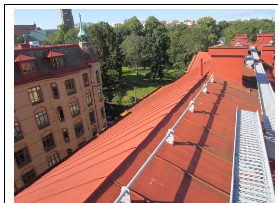
Befintligt plåttak mot Götabergsgatan
