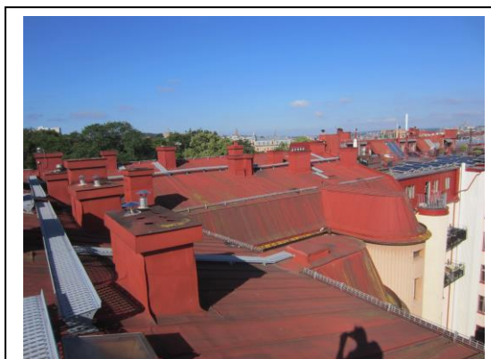
Befintligt plåttak mot gård
